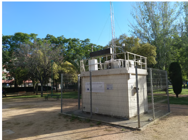
Estación de Lepanto después del tratamiento
